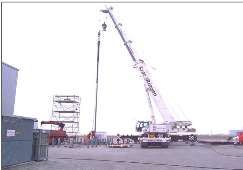
Figur 36: Udskiftning af dykpumpe på Amager.
